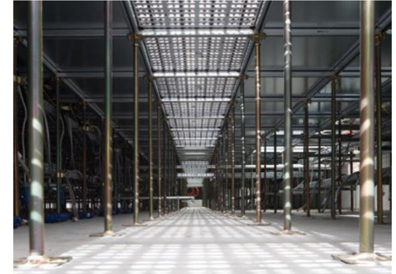
Der Doppelboden – hier verläuft das Adersystem für die Stromversorgung im Datacenter Leipzig.
